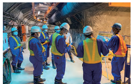
幌延研修 - 地下坑道
